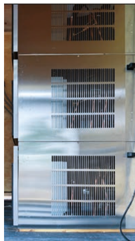
Levering af isværk bestående af 3 stk. IM-240 isterningemaskiner med en samlet isproduktion på 3 x 210 kg. pr. døgn samt en HI-CLASS Top 65 drikkevandskøler med kabinet.
